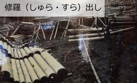
修羅出しは材木を溝状または枕木状に並べてその上を滑らせて丸太を一か所に集める手法です。丸太がうまく滑っていくような傾斜・カーブの設計や中継所の選定が必要だったと予想されます。滑ってくる木材を中継所や土場(どば)に落とす役を馬子(まご)、馬子が落とした材木を整理して積み上げる役を木直しといいます。彼らは独特の合言葉を用いるなどして連携し安全に配慮していたそうです。
